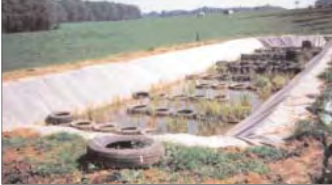
Een pas aangelegd vloeiveld
