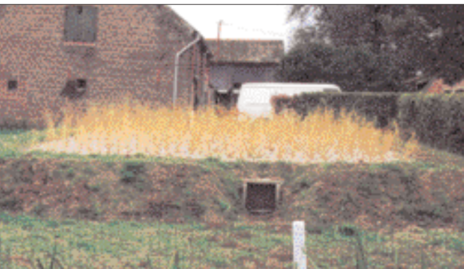
Een pas aangelegd percolatieveld
