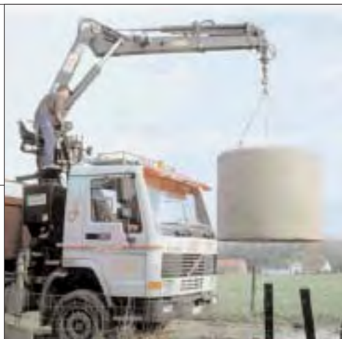
Plaatsing van een betonnen regenwaterput
